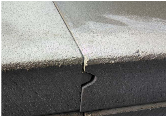
Een toepasselijk en efficiënt licht omkeerdak-isolatiesysteem vormt een dek met lichte sandwichpanelen waarvan de isolatielaag met hol-en-dol op de langsrichting de panelen verbindt. De bovenlaag van de panelen wordt gevormd door een dun, glasvezel gewapend betondek, dat tevens als kleine ballastlaag functioneert. Een dergelijk isolatiesysteem vormt een ideale basis voor opstelling van PV. © ejn
