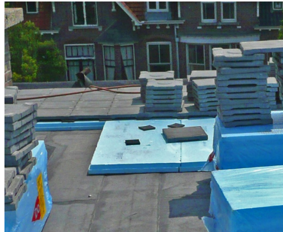
Links: restauratiedetail van dakisolatie volgens de warmdak formule, rechts een omkeerdak-isolatie in uitvoering. In beide gevallen wordt een R-waarde van 2,5 m 2 K/W bereikt. © ejn
