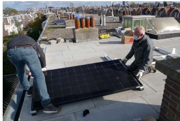
Een toepasselijk en efficiënt licht omkeerdak-isolatiesysteem vormt een dek met lichte sandwichpanelen waarvan de isolatielaag met hol-en-dol op de langsrichting de panelen verbindt. De bovenlaag van de panelen wordt gevormd door een dun, glasvezel gewapend betondek, dat tevens als kleine ballastlaag functioneert. Een dergelijk isolatiesysteem vormt een ideale basis voor opstelling van PV. © ejn
