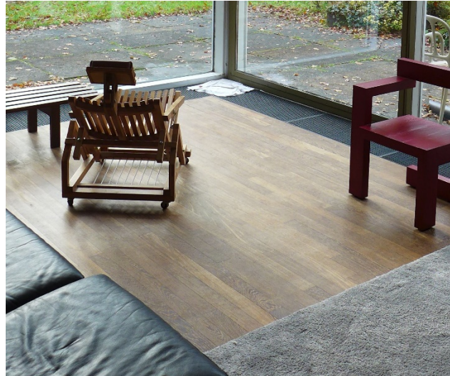
Dat de ongeïsoleerde, met Wengé-parket afgewerkte stenen vloer van de woonkamer, boven de kruipruimte niet als coldspot toont komt puur door de grote hoeveelheid warmte die in de kruipruimte wordt opgewekt door de niet en slecht geïsoleerde verdeellicingen van de CV en de ongeïsoleerde convectorputten. © ejn
